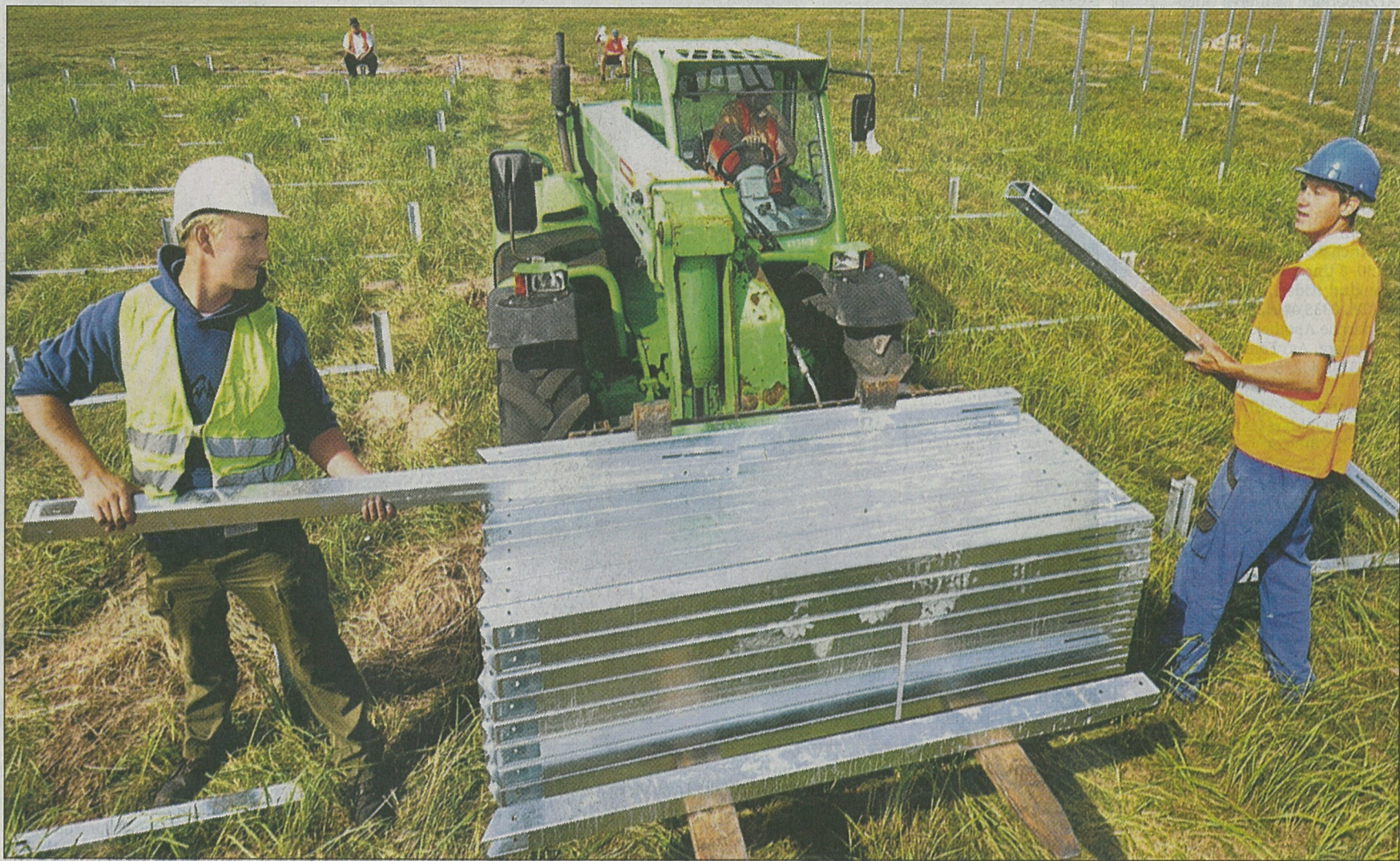
Wer will fleißige Handwerker seh'n? Bauarbeiter laden Stellbeine vom Gabelstapler. Darauf sollen in den kommenden Wochen die Modultische installiert werden. Bis zum 30. September muss der Solarpark auf einer Fläche von 280 Hektar in Betrieb genommen werden. Foto: Johann Müller
